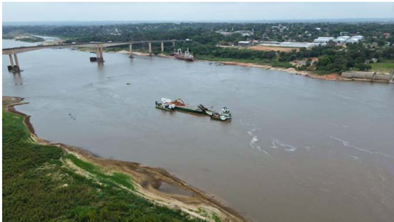
Proyecto Derrocamiento Piedra Remanso Castillo
