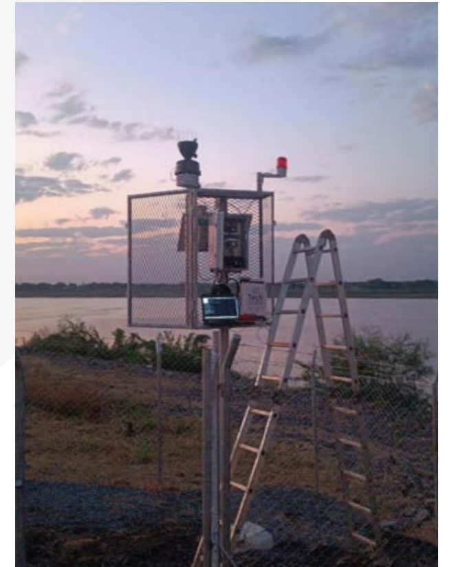
Estación hidrométrica automática
